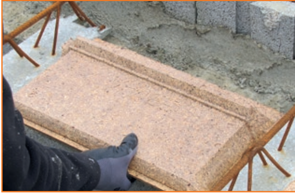
1 Pose des bouts. EBM-A aux appuis.
