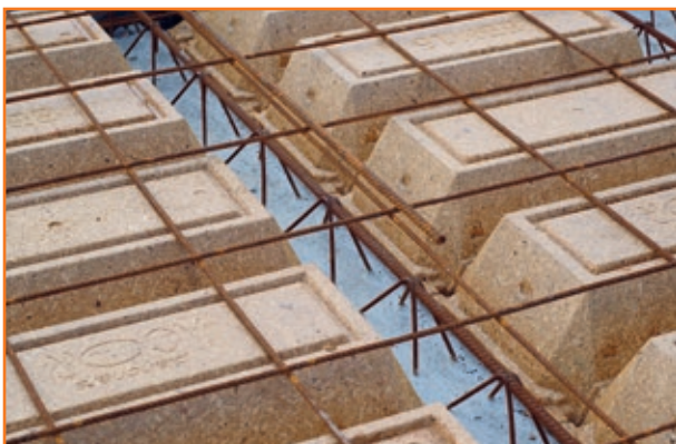
5 Etaisement si nécessaire puis ferrailage.
