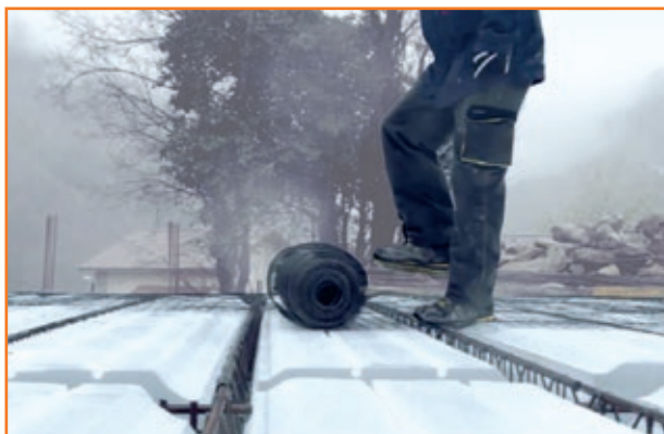
1 Pose du plancher ECOTHERM et du treillis 5x5.
