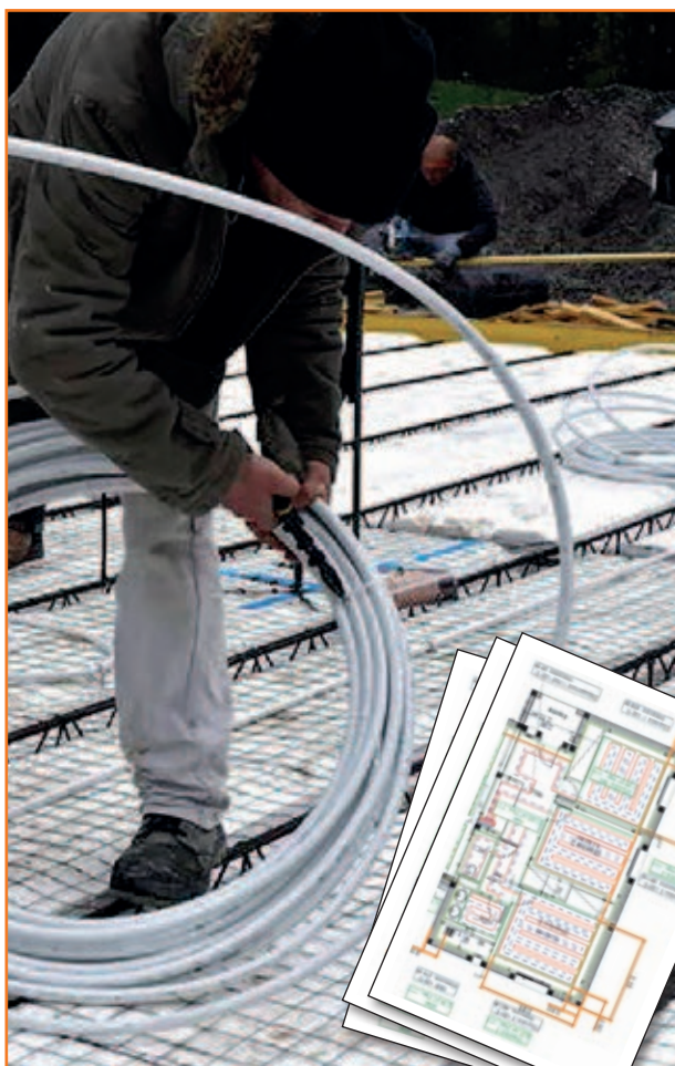
3 Mise en place des tubes UPONOR suivant plan de pose.
